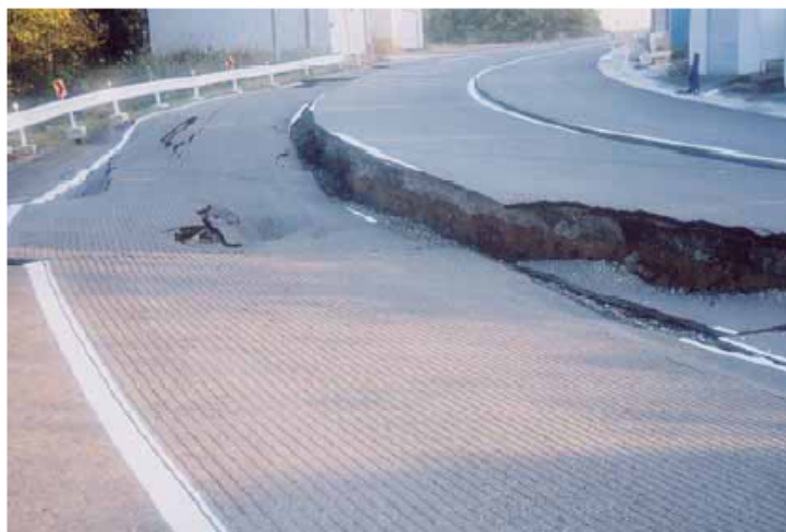
写真－2 盛土された道路の陥没
