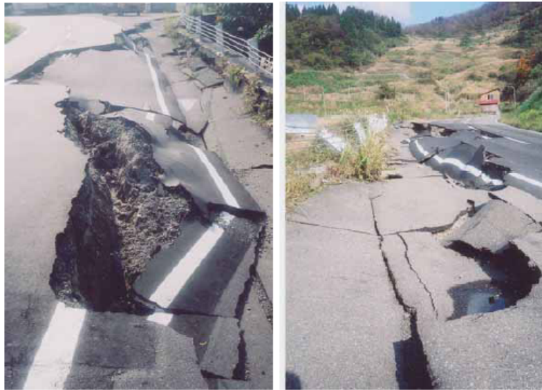
写真－1 道路面の斜面方向への陥没
