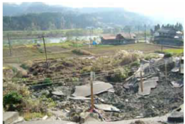
写真-6 盛土崩壊箇所
