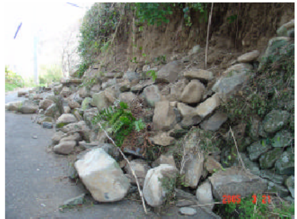
写真－9 原地斜面の崩壊
