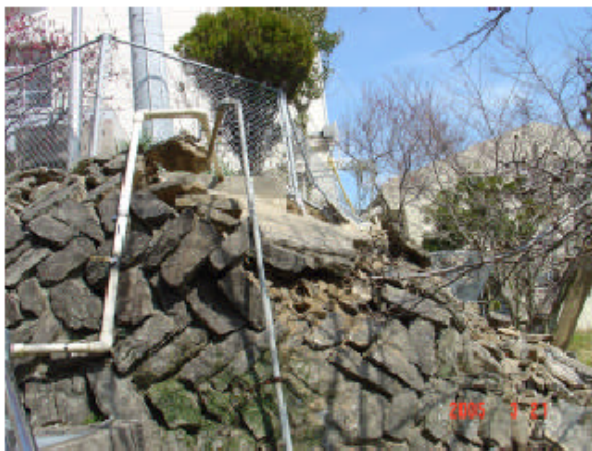
写真－8 盛土斜面の崩壊
