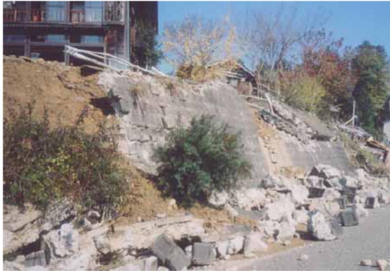
写真-4 家屋の下のもたれ擁壁の崩壊
