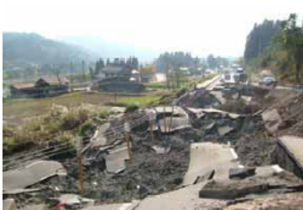
写真-6 盛土崩壊箇所
