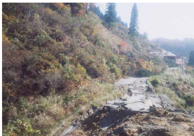
写真－3 沢地形に盛られた道路盛土の崩壊
