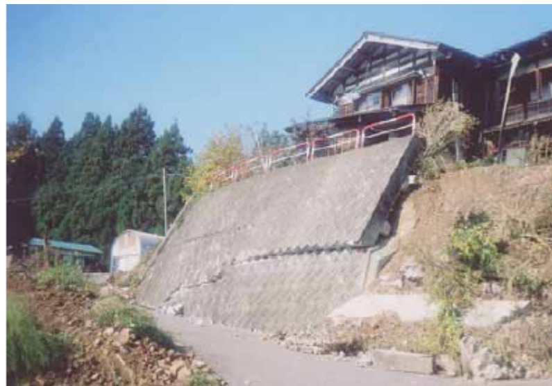
写真-5 ブロック積み擁壁の崩壊
