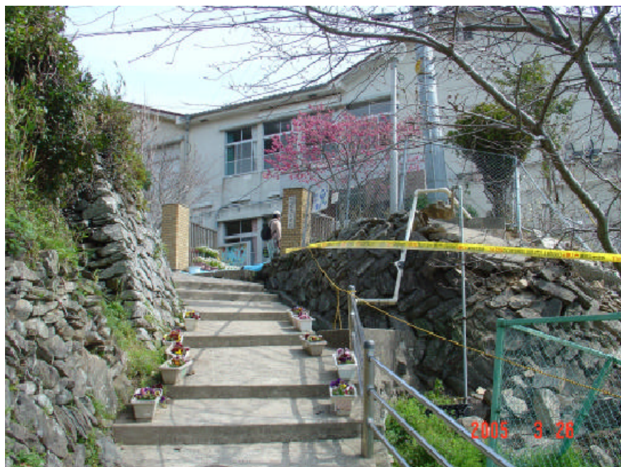
写真－10 崩壊した道路右側の盛土斜面と崩壊しなかった左側の切土斜面
